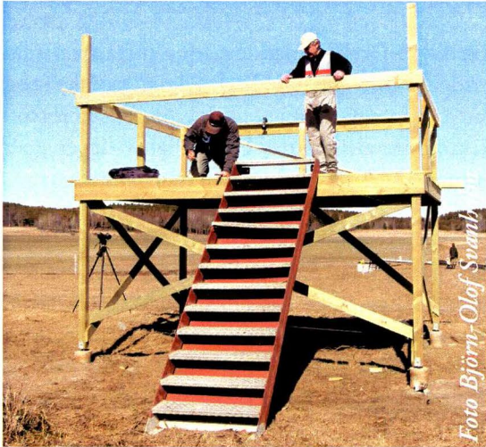
Plattformen under byggnad
